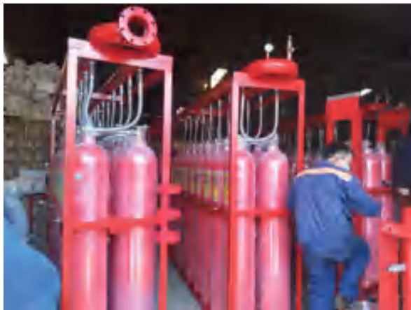
Công nhân đang lắp đặt hệ thống khí
