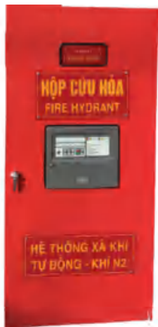
Trung tâm báo cháy kết hợp điều khiển xả khí
