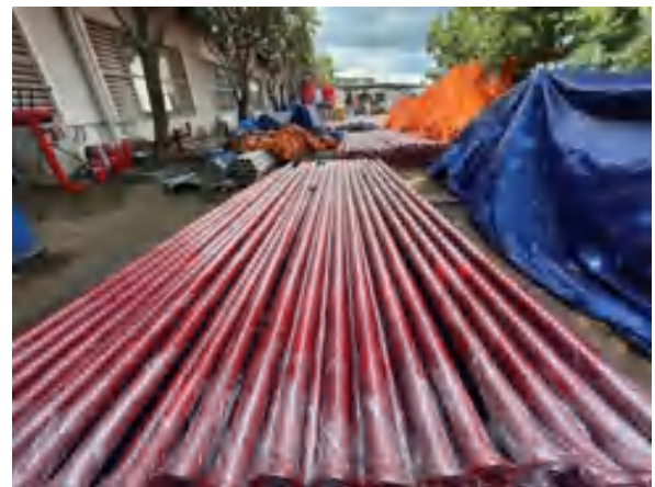
Đường ống lắp ráp cho công trình
